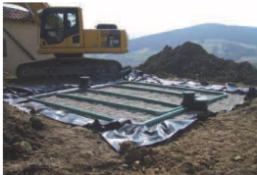
Travaux de réalisation d'un filtre à sable
