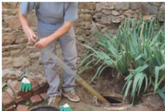
Mesure du niveau de boues par un technicien du SPANC
